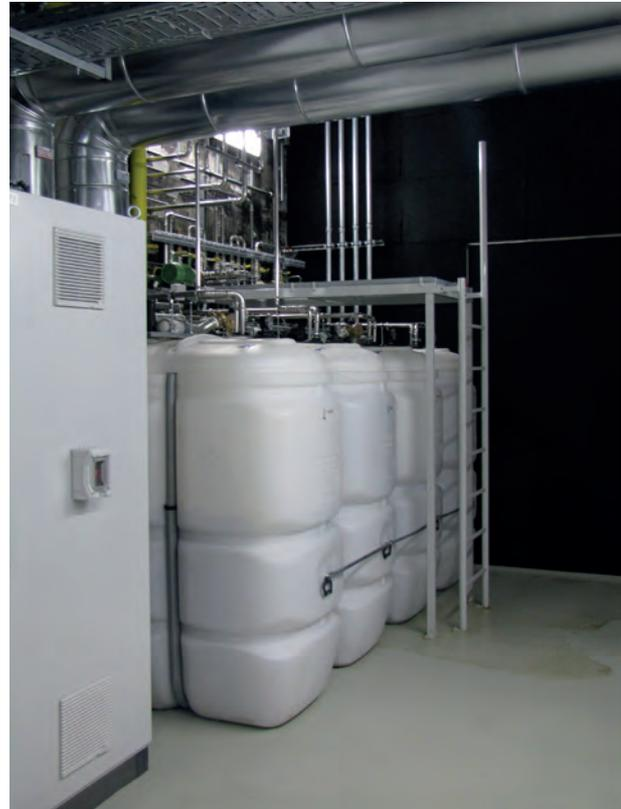
Bild 3: Motorenöltanks
