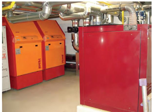
Bild 3: Brennwertkessel
