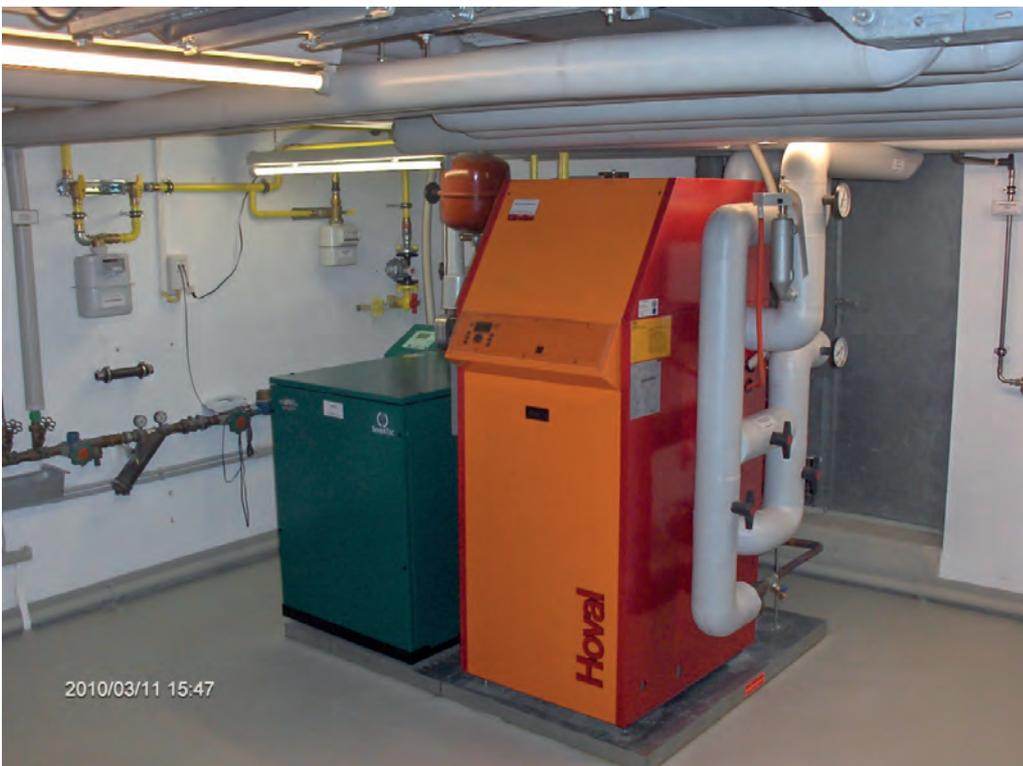
Bild 2: BHKW und Spitzenlastkessel
