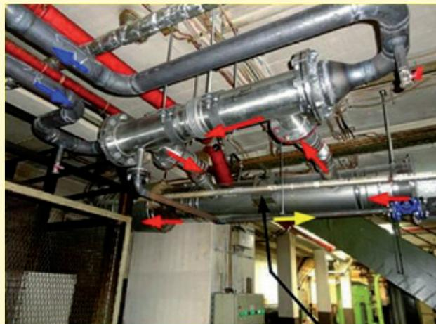
→ Heizwasser    → Dampf    → Kondensat    → Klappe im Kamin
