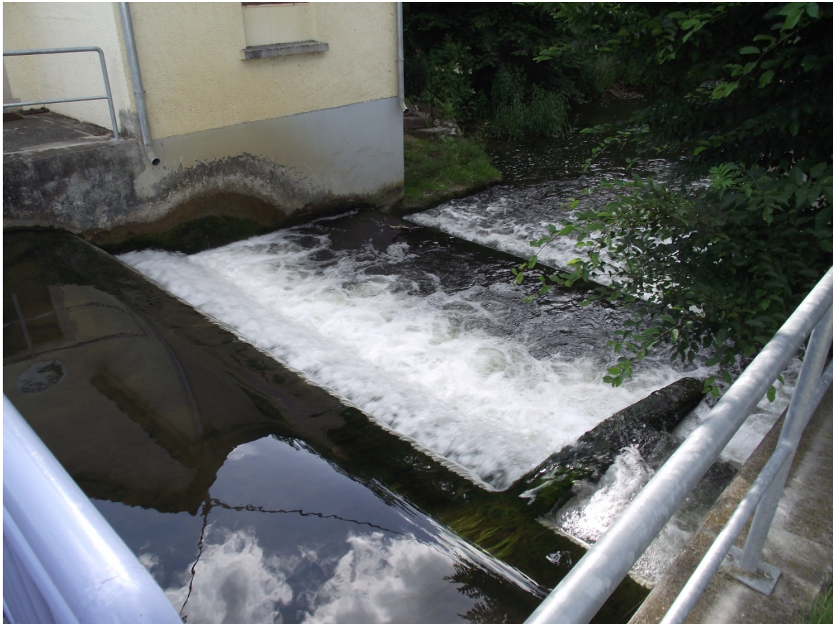
Abbildung A3-2: Sohlenbauwerk 590000000358
